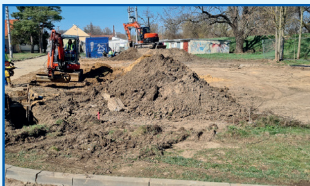
Zahájení zemních prací pro realizaci RN
