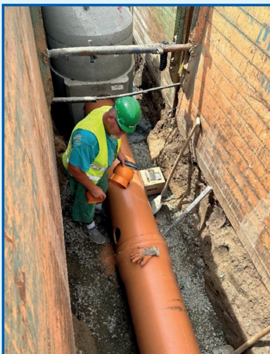
Montáž nového plastového kanalizačního potrubí v ulici Poříčí
