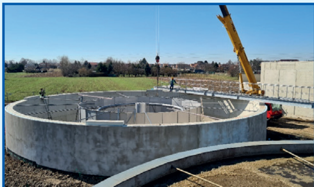
Práce na vystrojení nádrže nové biologické jednotky
