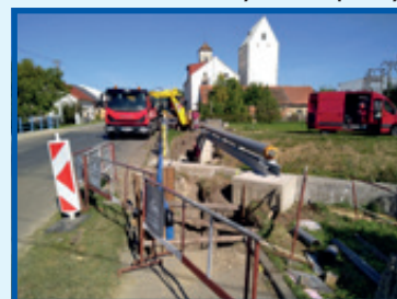
Výměna potrubí nad vodním tokem „Polní potok“ v Novosedlech
