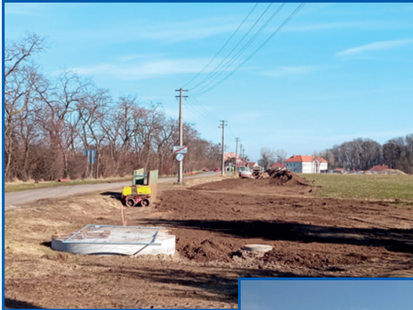
Stavba Pohořelice-Velký Dvůr, kanalizace
