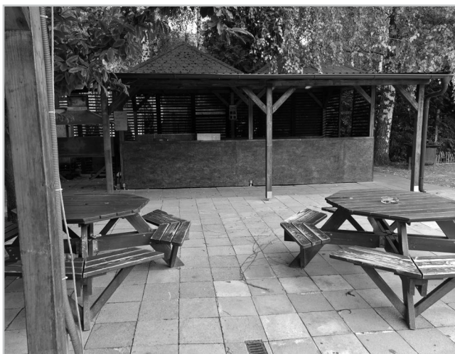
Nahoře – pokládání dlažby; dole – přístřešek u stánku.
