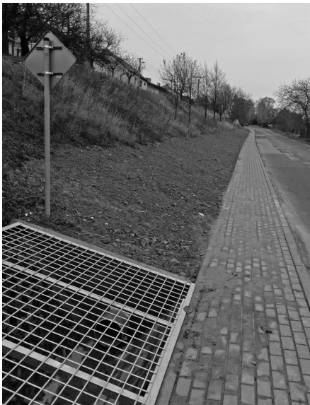
Foto č. 1 – zatrubnění příkopu v horní části obce. Foto č. 2 – rozšíření horní zastávky.
