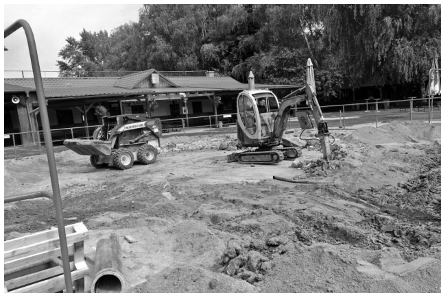
Probíhá oprava a rekonstrukce malého bazénu – bourání bazénu.
