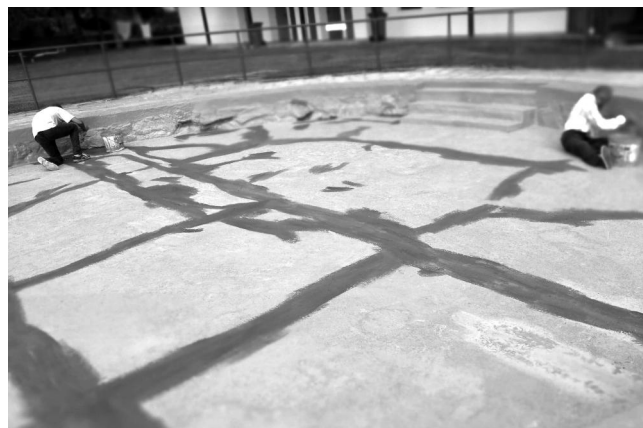
Práce při opravě dětského bazénu. Foto: archiv TJ SPORT Němčičky, z. s.
