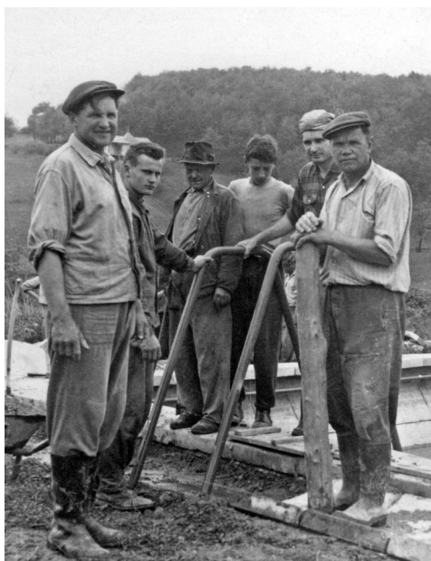
Budování žlabů kolem velkého bazénu - asi 1963/1964.
