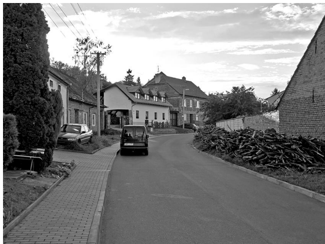
Rekonstrukce komunikace od školy na Kácperk.
