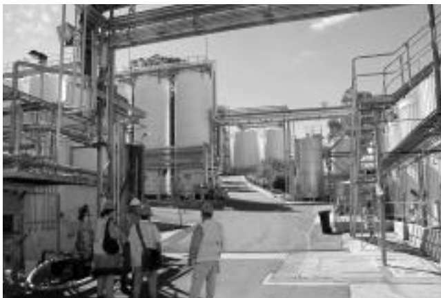
Velkokapacitní výroba vinařství Jacob's Creek, všude rozvody nerezových trubek a v popzdálí nádrž na 2 miliony litrů vína.
