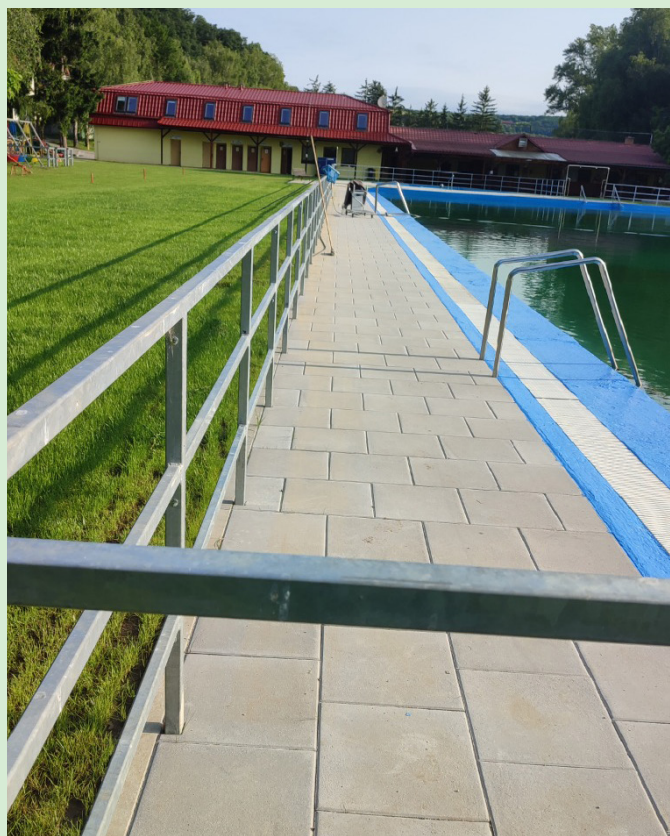
Bazén od jara lemuje nová dlažba i zábradlí.
