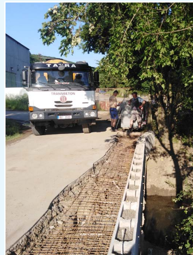
Výstavba opěrné zdi na mostku za areálem ZD
