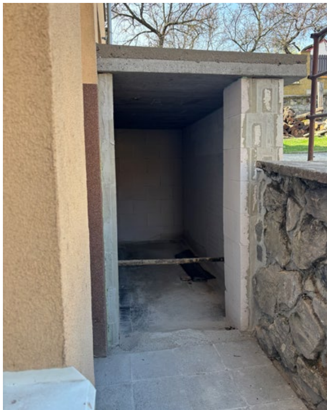
Foto: Nově přistavená místnost k budově obecního úřadu, která bude sloužit jako kotelna.
