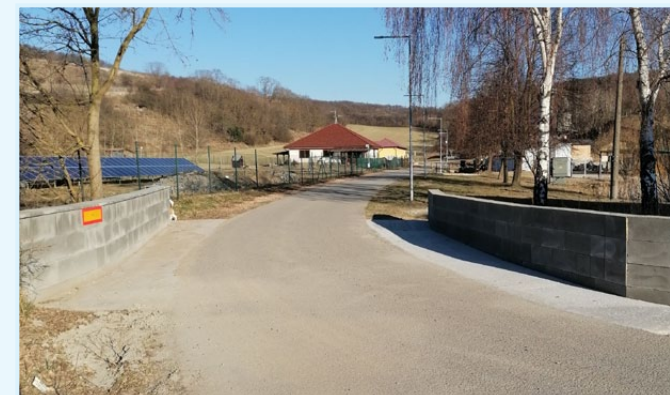
Mostek u sběrného dvora prošel zaslouženou rekonstrukcí. Z potoka, který pod ním protéká, byly už vloni odstraněny nánosy bláta.
